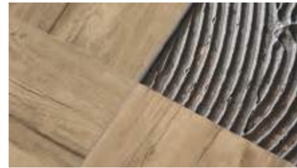
Laying on screed with adhesive. Colocación con adhesivo.
