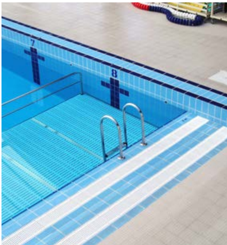
Detalle de piscina deportiva / Sports pool detail · Sistema Finlandés / Finish system
